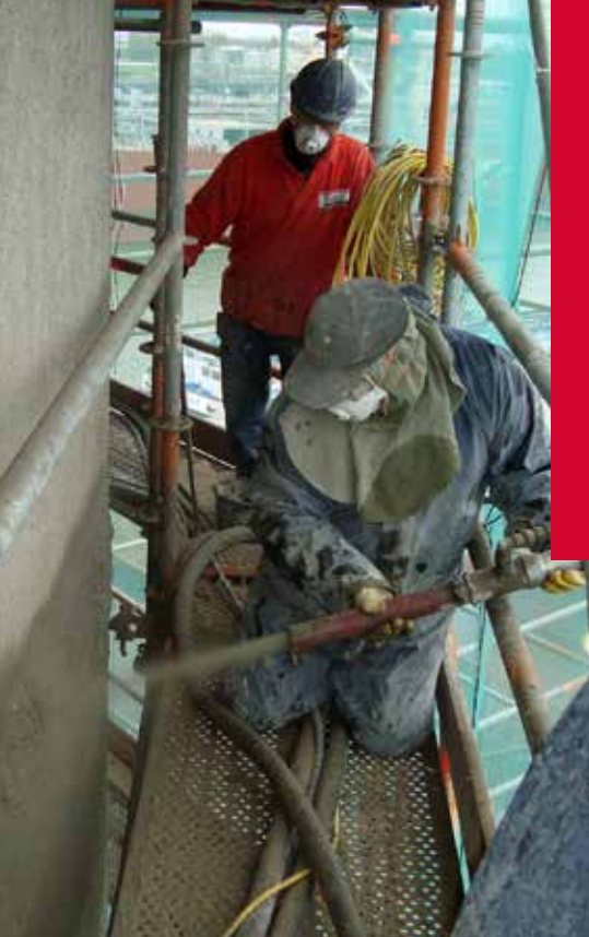
Aanbrengen spuitbeton volgens de droge methode
