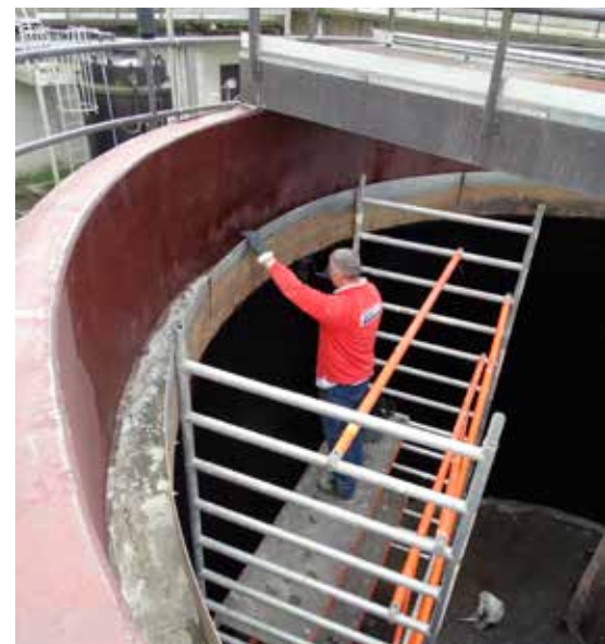
Aanbrengen beschermlaag
