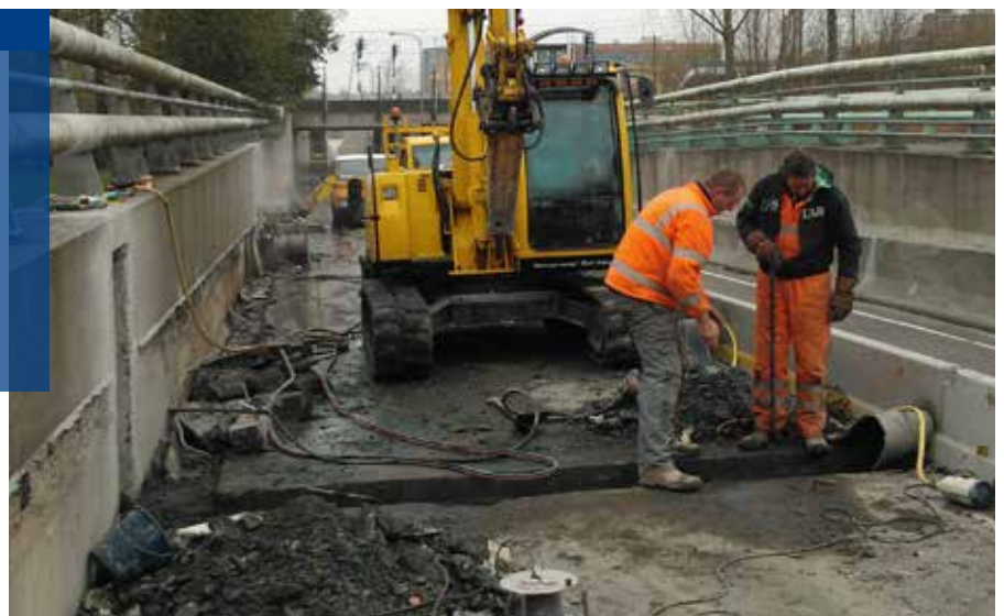
Voor het plaatsen van de nieuwe rubberen profielen werden diepe sleuven vrijgemaakt.
