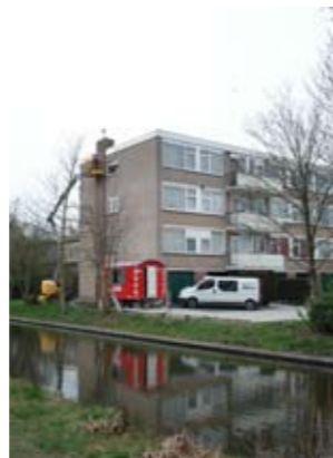
Dakranden worden gerepareerd.
