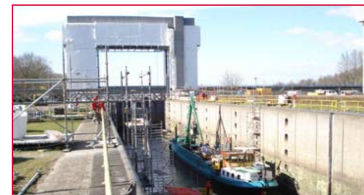
Werkzaamheden in de Irenesluis
