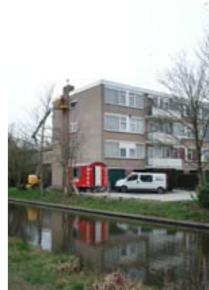
Dakranden worden gerepareerd.
