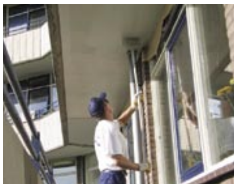
Conservering van de onderzijde van de galerijen
