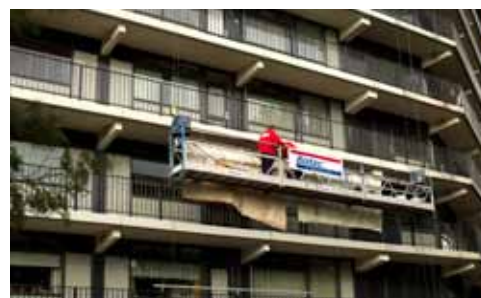
Werkzaamheden vanuit de hangbrug.
