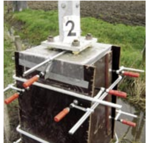
De poer is bekist en aangestort
