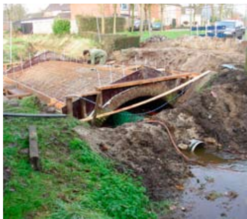
Renovatie van de gemetselde duiker.
