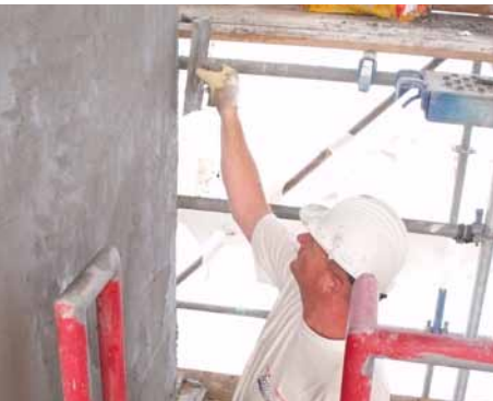
Batec voert de betonreparaties uit
