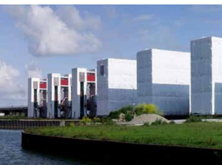
Het betreft totaal zeven spuitorens
