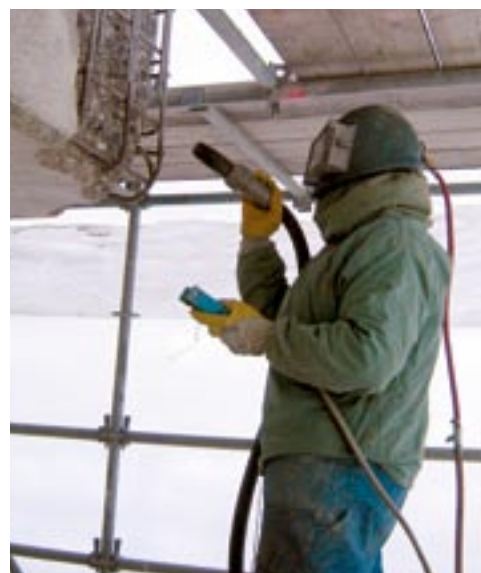
Reinigen van de ondergrond door gritstralen
