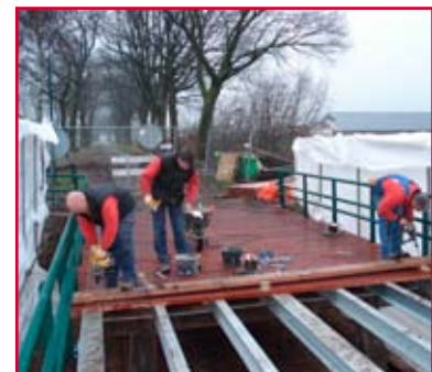
Renovatie bruggen over het Peelkanaal.
