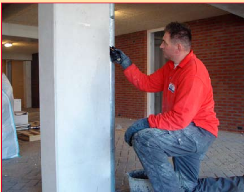
Beton wordt door Batec vakkundig hersteld.
