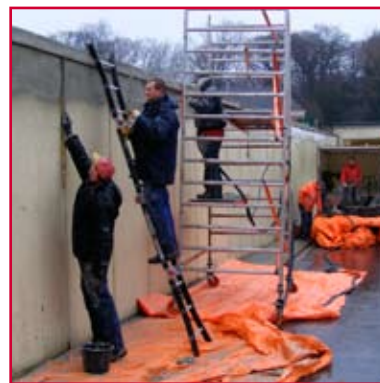
De spoortunnel in Voorschoten wordt volledig gerenoveerd.
