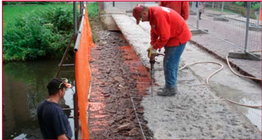
Impressie van het werk aan één van de bruggen.
