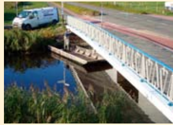
Brugrenovatie in Den Helder.
