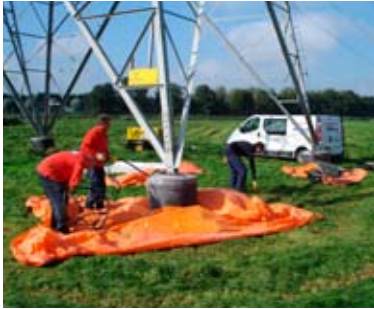
Masten Tennet worden gerepareerd.
