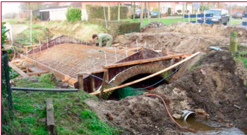
De gemetselde duikerbrug in Wanroy werd vakkundig gerepareerd.
