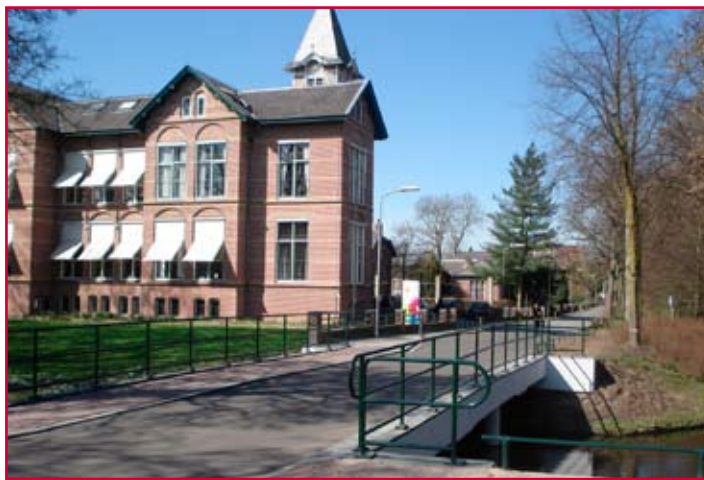
Eén van de drie bruggen die Batec renoveerde in Wageningen.
