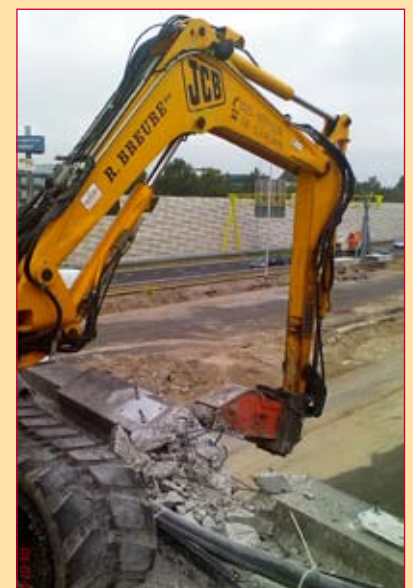
Verwijdering van beschadigd beton.
