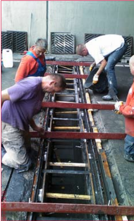
Aangetaste waterafvoergoot wordt gerepareerd.
