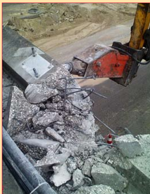
Verwijdering van beschadigd beton.
