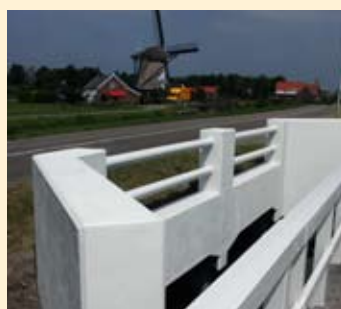
Beton als nieuw in Uitgeest.
