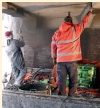
Aanbrengen spuitbeton
