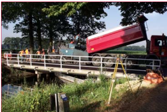
Aanbrengen asfaltafwerking
