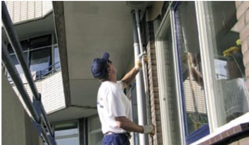
Conservering van de onderzijde van de balkons
