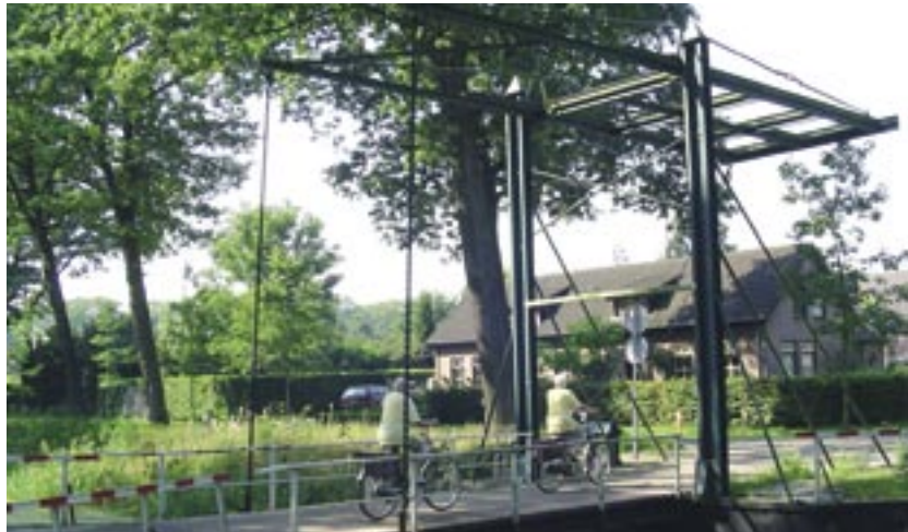
Monumentale stalen ophaalbrug weer opgesteld voor fietsplezier
