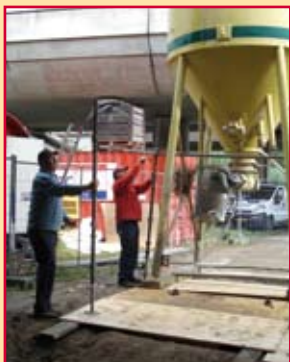
Inrichten van de bouwplaats.
