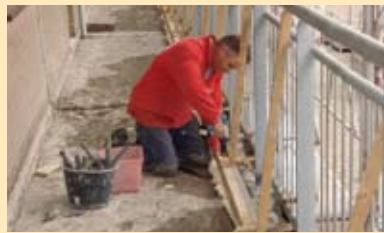
Plaatsen van de bekisting voor de schrobranden.
