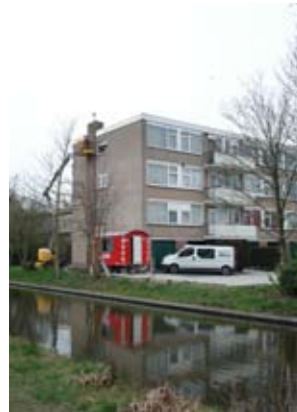
Dakranden worden gerepareerd.
