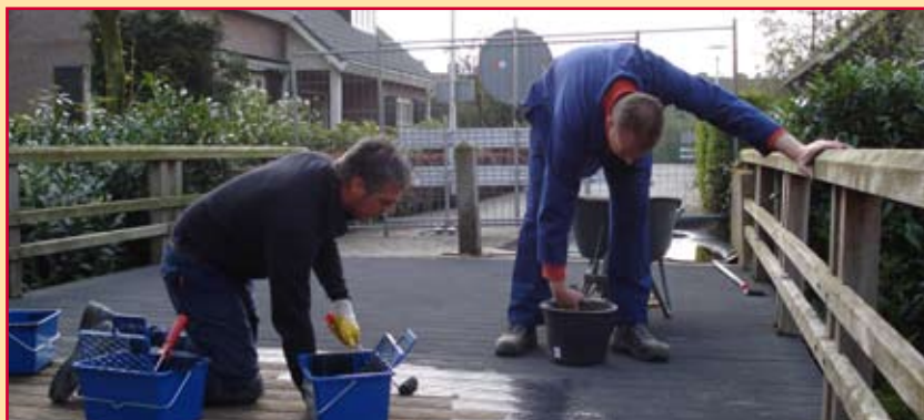
Batec is bekend van betonreconstructies, maar voelt zich ook thuis op hout.
