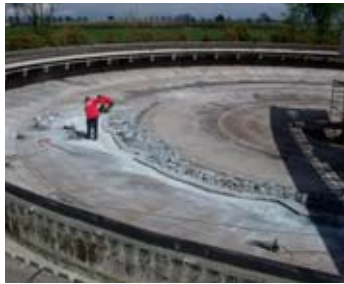
Sloopwerk losliggende vloer
