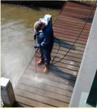
Reinigen van houten dekplanken
