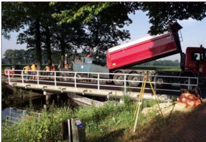
Aanbrengen asfaltafwerking
