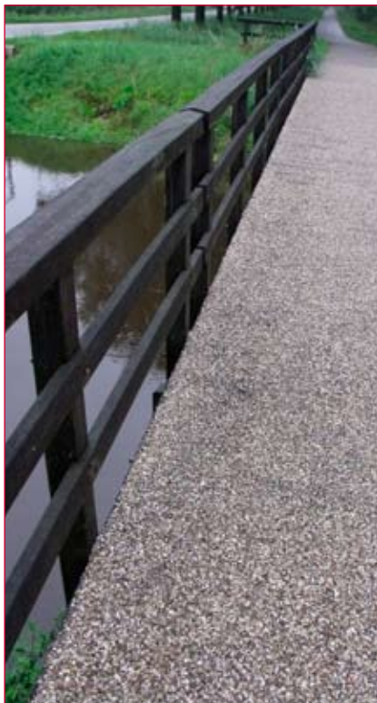
De nieuwe slijtlaag is aangebracht
