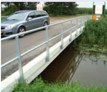
De brug weer klaar voor gebruik
