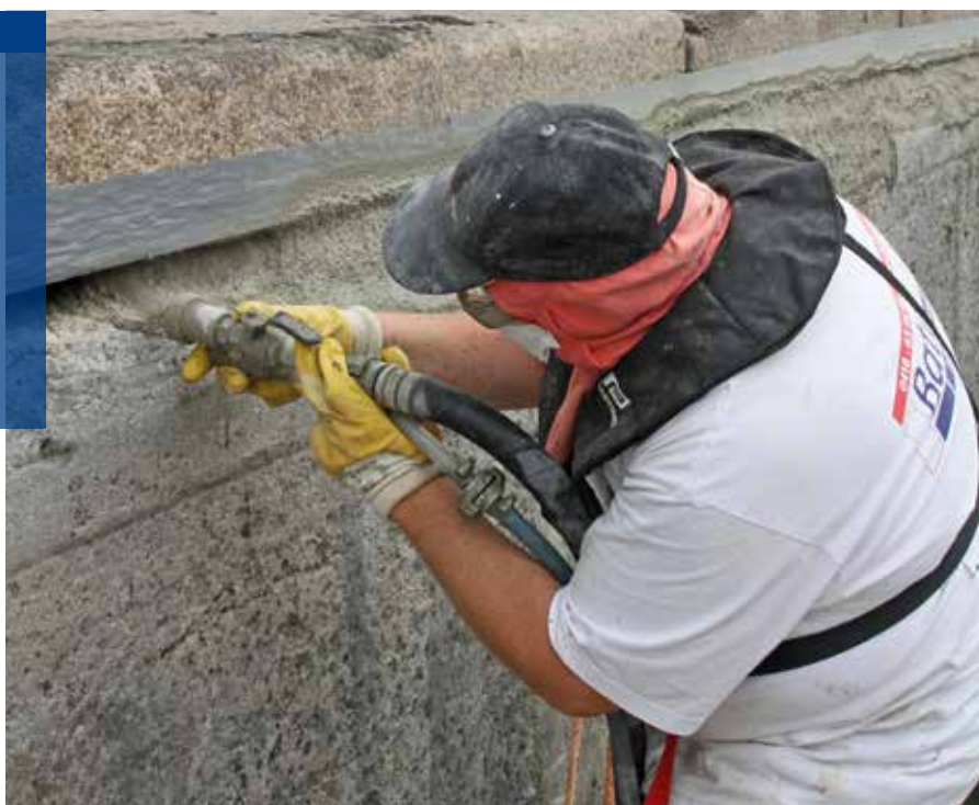
De betonschade aan de kademuren wordt met twee lagen spuitbeton hersteld.
