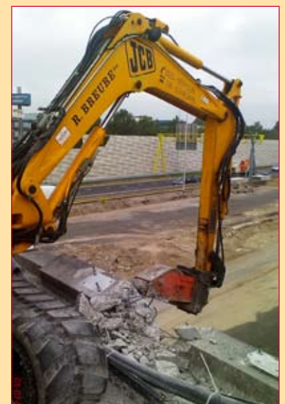
Verwijdering van beschadigd beton.
