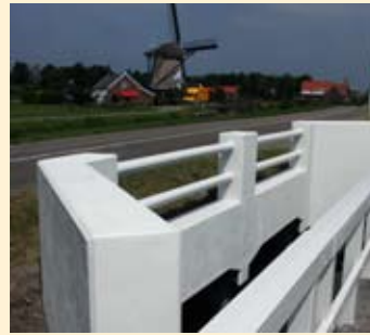
Beton als nieuw in Uitgeest.
