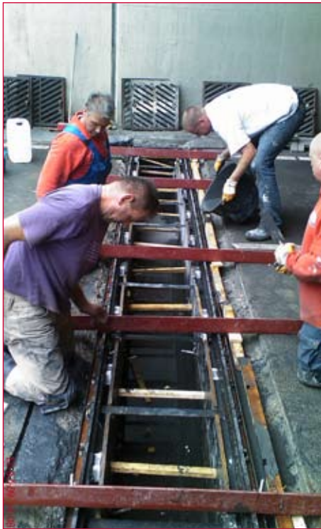
Aangetaste waterafvoergoot wordt gerepareerd.
