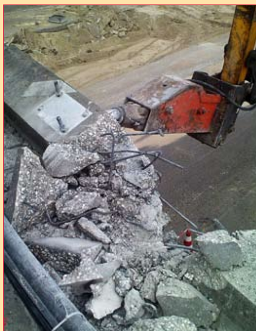
Verwijdering van beschadigd beton.
