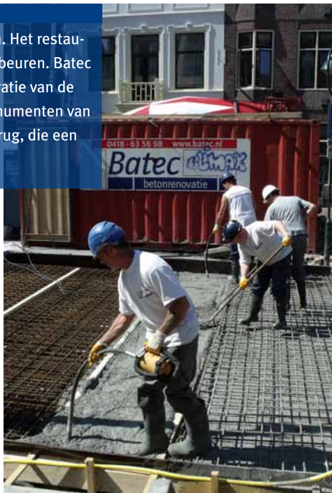
Eén van de belangrijkste watermonumenten van Gouda is onlangs door Batec gerenoveerd
