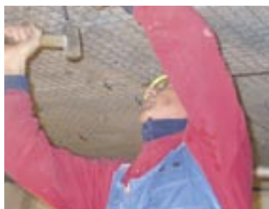
Bevestigen RVS wapening
