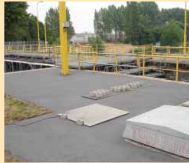
Sluis in Weurt.
