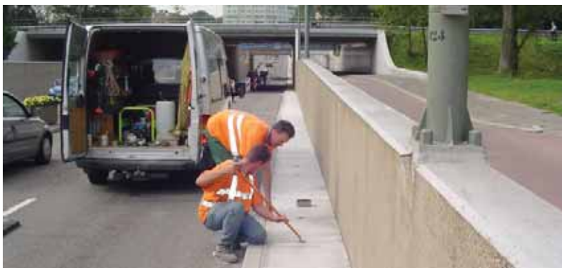
Tijdens de werkzaamheden kon het verkeer gebruik blijven maken van de tunnel.
