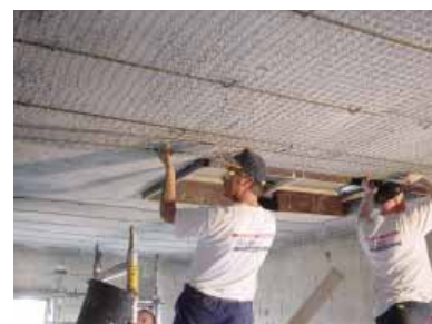
Aanbrengen RVS wapeningsnet.
