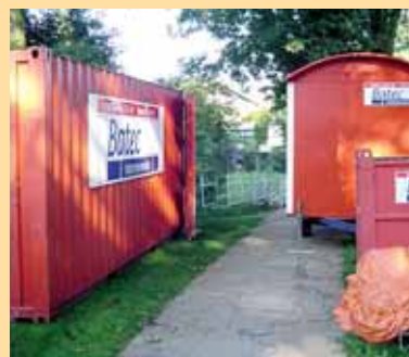
Batec zorgt goed voor materiaal (links: opslag) en mensen (rechts: bouwkeet).
