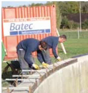
Aanbrengen van omlooprand.
