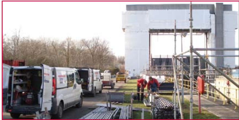
De werkzaamheden aan de Irenesluis werden in recordtempo uitgevoerd.
