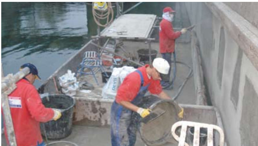
Medewerkers van Batec aan het werk in de Marijkesluis.
