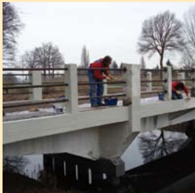
Schilderwerk aan brug.
